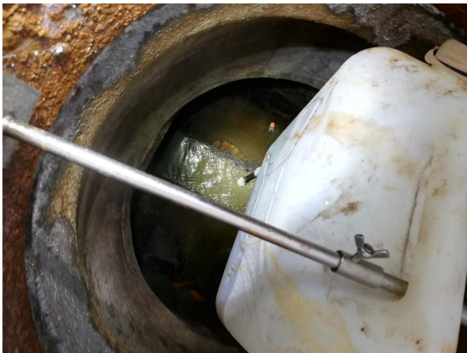
Foto 2: Tilsætning af bakterieblanding med drypvanding i brønd i spildevandsledningen i Jægergårdsgade, december 2019. Foto: Bjarne Dagø, Aarhus Vand A/S.
