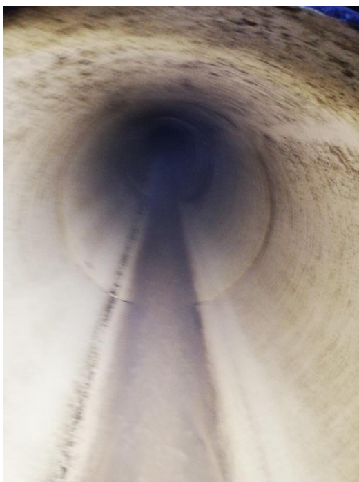
Foto 1: Spildevandsledningen i Jægergårdsgade, december 2019, efter at bakterieblanding har omsat og fjernet belægninger mv. Foto: Bjarne Dagø, Aarhus Vand A/S.
